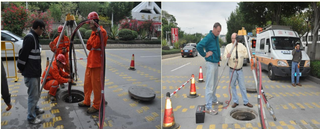
福建泉州修复项目现场施工
